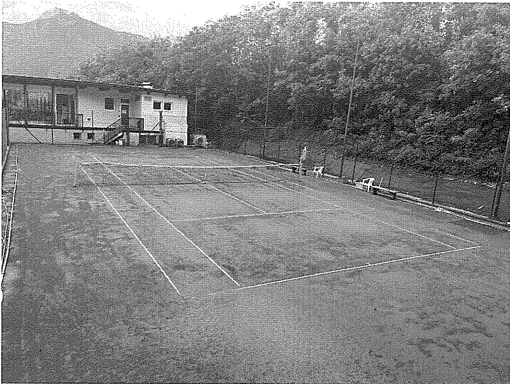
vista verso sud-ovest
