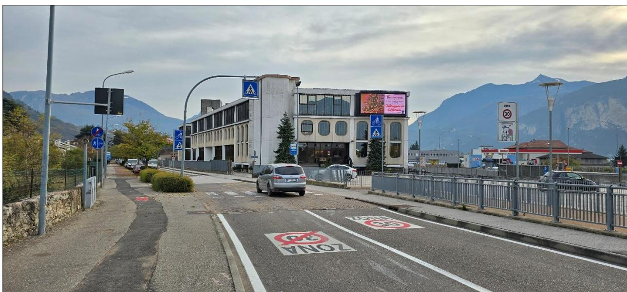
Per ridurre le velocità di attraversamento (velocità massima rilevata nel post sperimentazione 92 Km/h con una media di oltre 260 veicoli ogni giorno che non rispettano il limite dei 50Km/h) e aumentare la permeabilità della strada da parte dell'utenza attiva, il progetto di consolidamento propone la realizzazione di un attraversamento pedonale rialzato all'altezza del numero civico 93.
