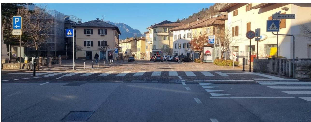
Il progetto prevede quindi la realizzazione di un'isola centrale non sormontabile per ridurre la larghezza della carreggiata e di conseguenza far percepire chiaramente all'automobilista l'attraversamento di una zona dove i comportamenti devono essere diversi: velocità moderate e attenzione ai pedoni e ai ciclisti.
