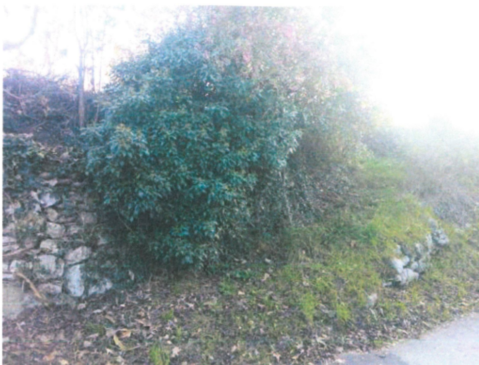
Foto n°3 vista del dislivello fra via Ariol e le aree oggetto dell'intervento
