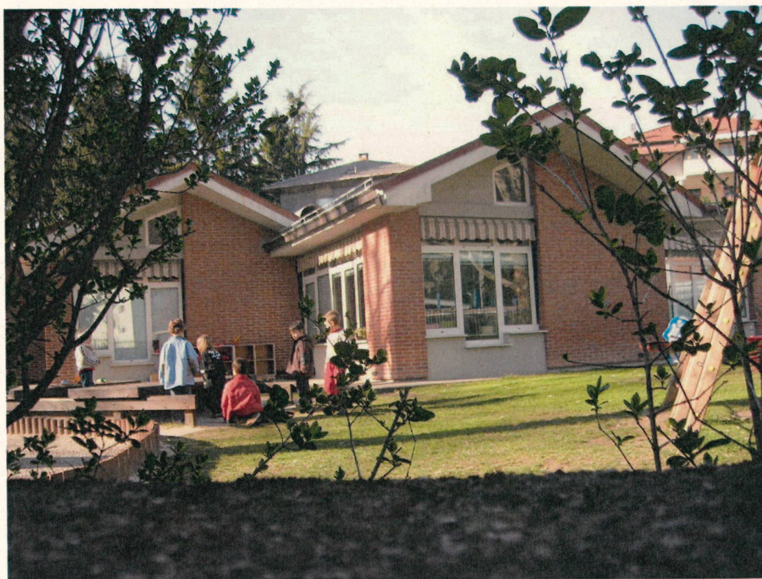
Foto 10: vista della scuola materna
