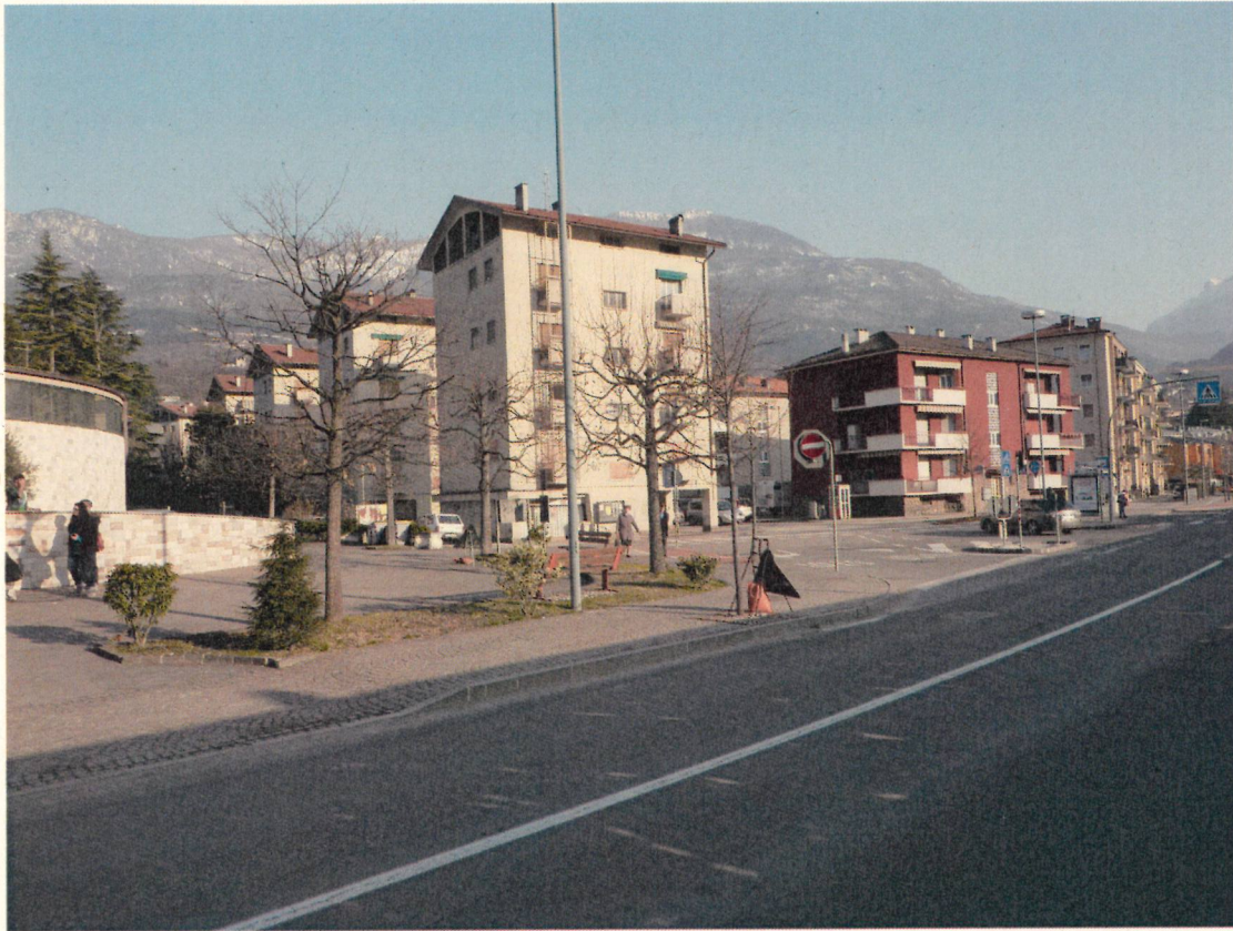
Foto 5: vista accesso da nord a viale dei Tigli da Viale Verona
