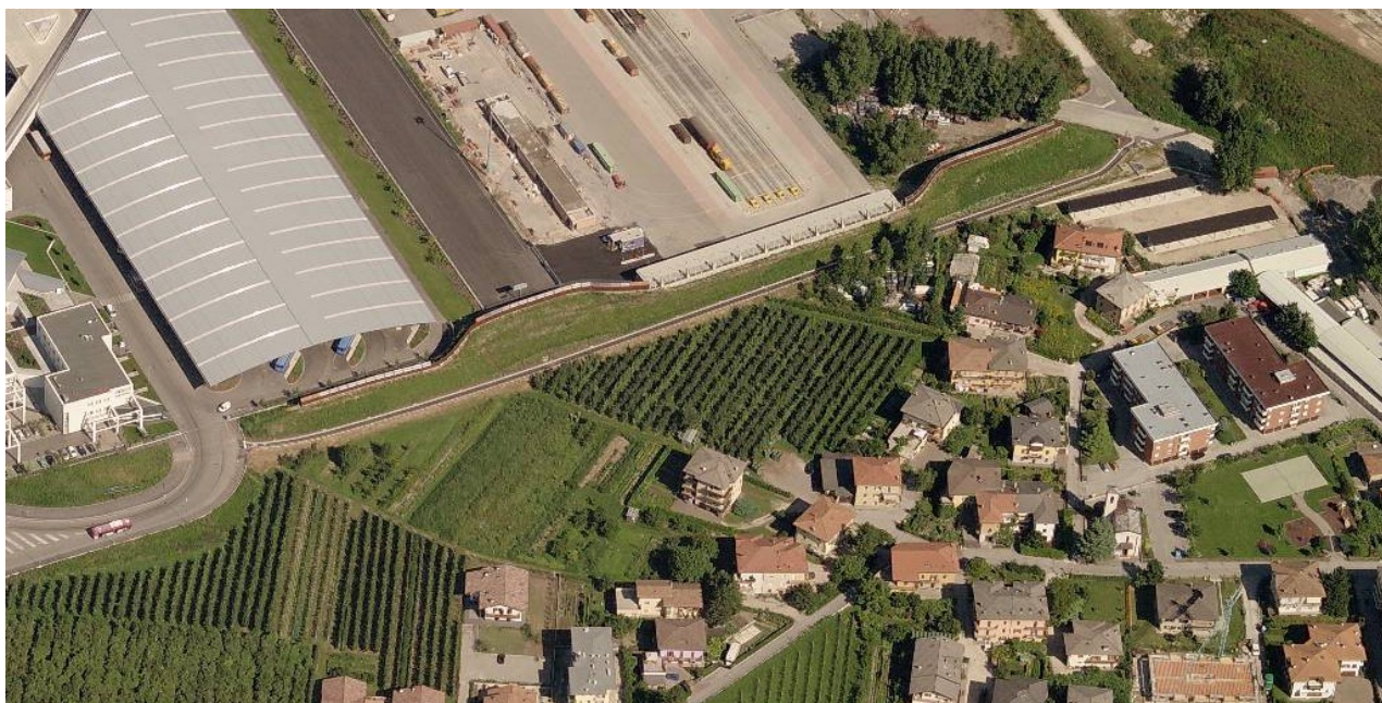
Figura 22: Barriera antirumore realizzata a ridosso dello scalo intermodale
