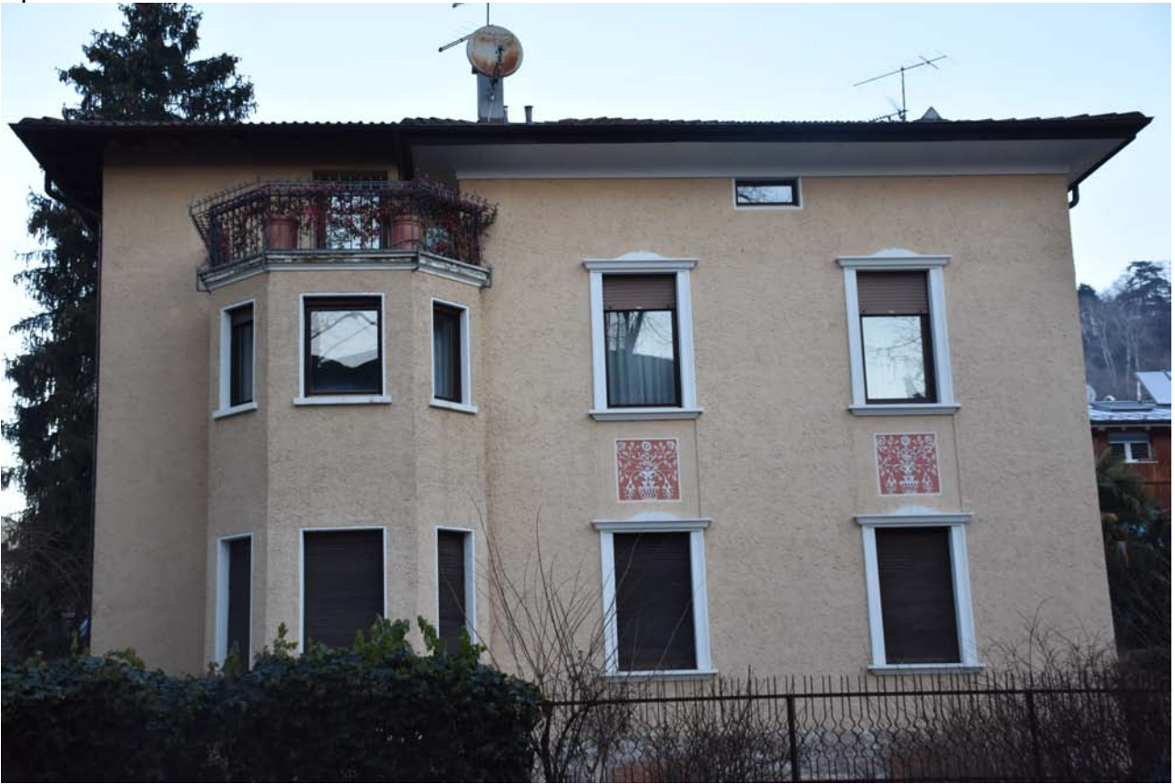
06. Trento, via Vicenza, Aie 241 (p.ed. 2341 C.C. Trento) Casa Stolcis ingg. Emilio Gaffuri e Guido Segalla Epoca di costruzione: 1927 – 1929
