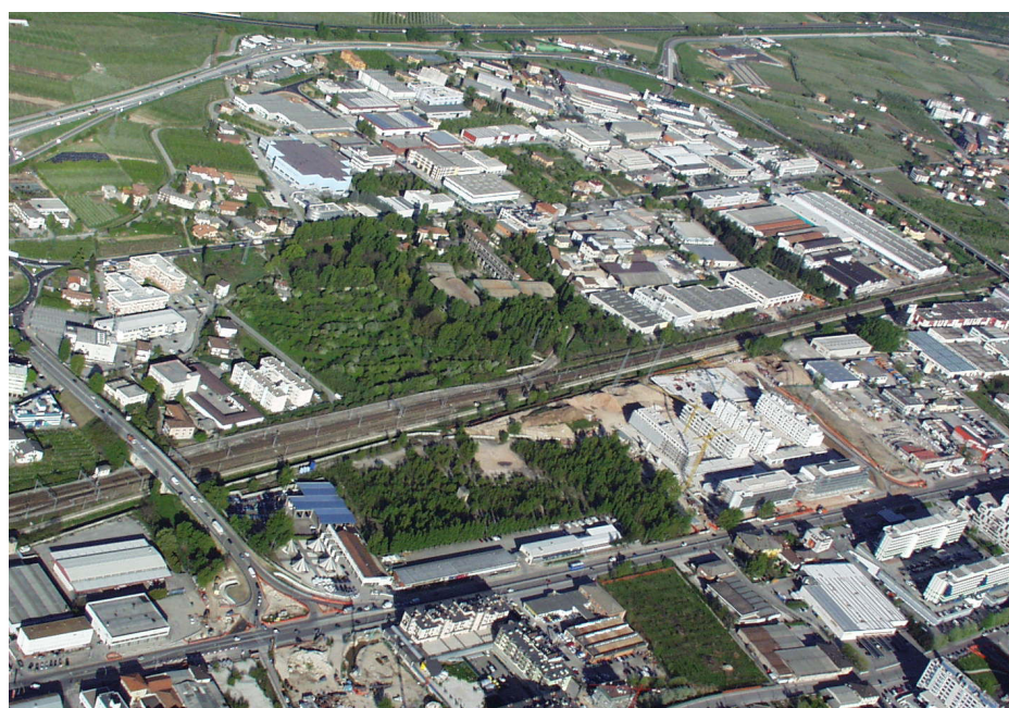
Fig. 7: Una recente veduta aerea delle aree di Trento Nord. Le zone alberate al centro dell'immagine sono le aree oggetto della bonifica.
