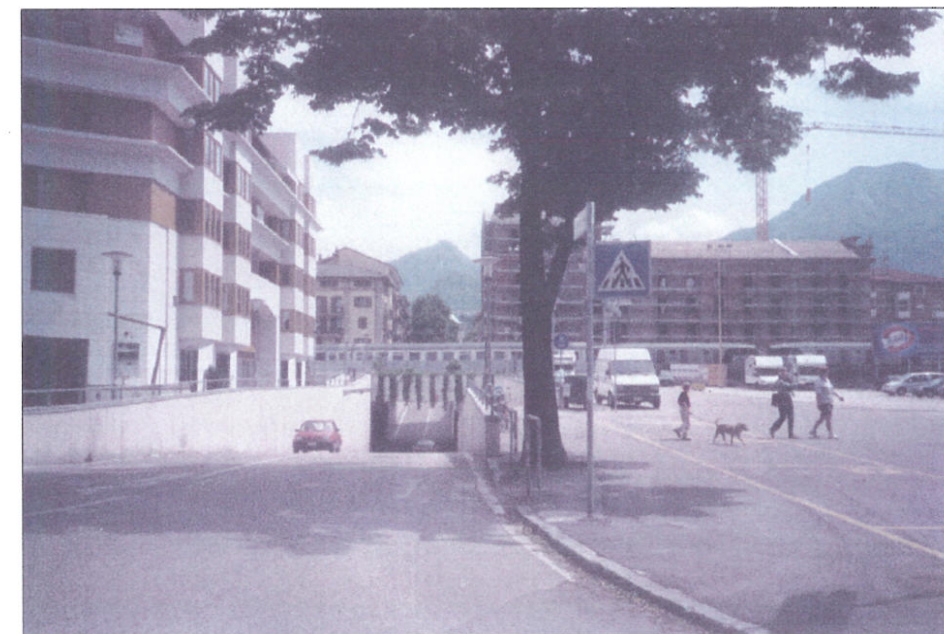
Sottopassaggio della via Giuseppe Verdi
