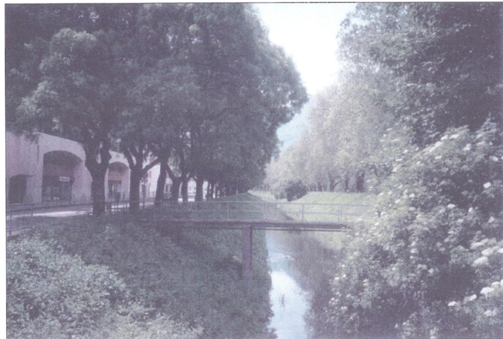
Ponte pedonale che attraversa l'Adigetto
