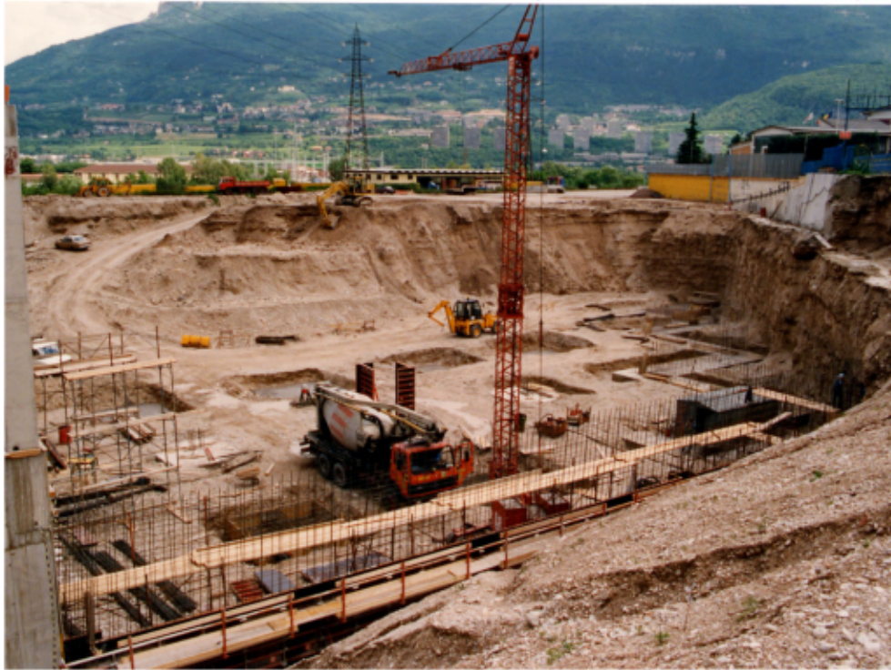
Foto 3. Panoramica da monte degli scavi realizzati negli anni '90 nell'ambito dei lavori di ampliamento della Cantina Ferrari.
