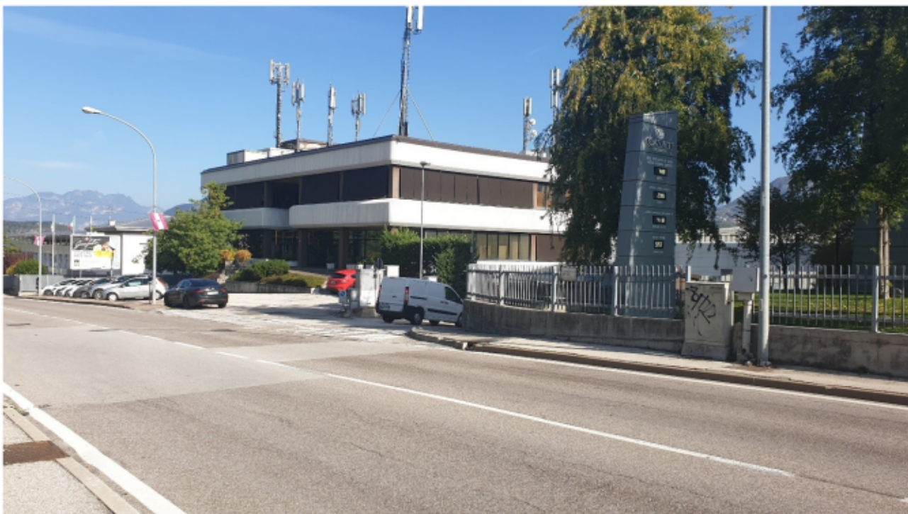
Foto 3. Vista della prima viabilità laterale
