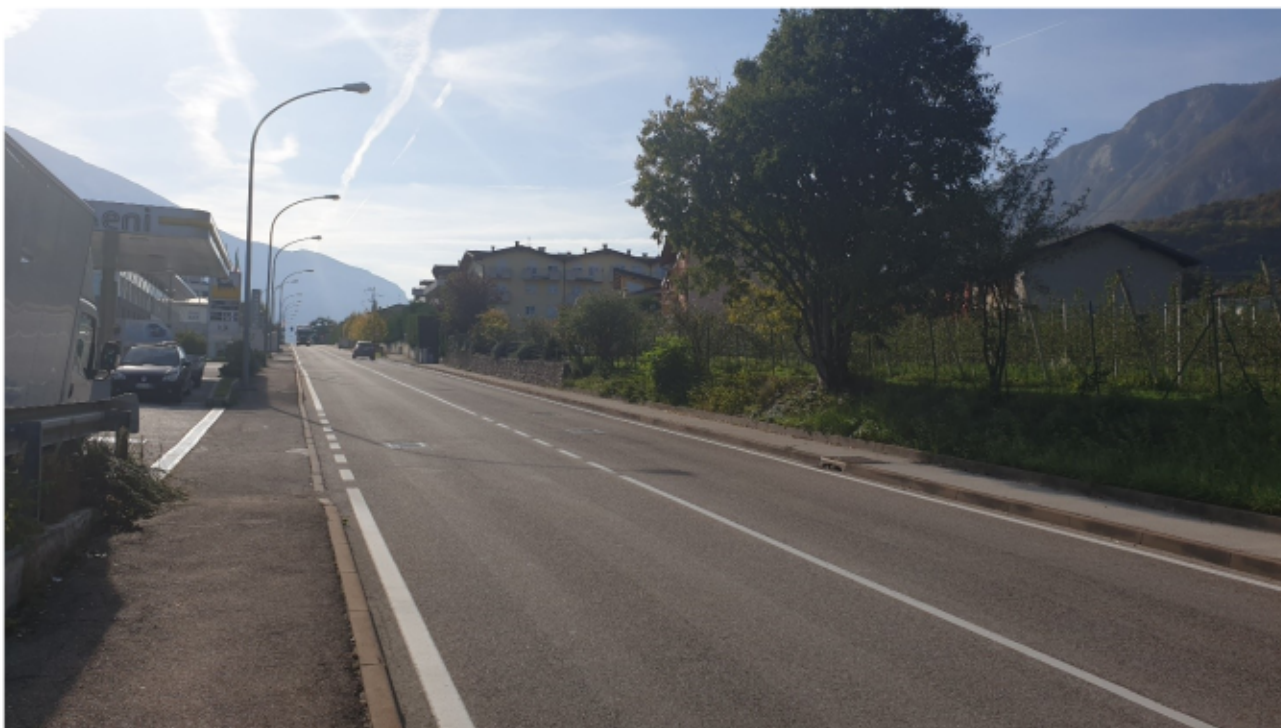
Foto 1. Particolare della sezione stradale di via del Ponte
