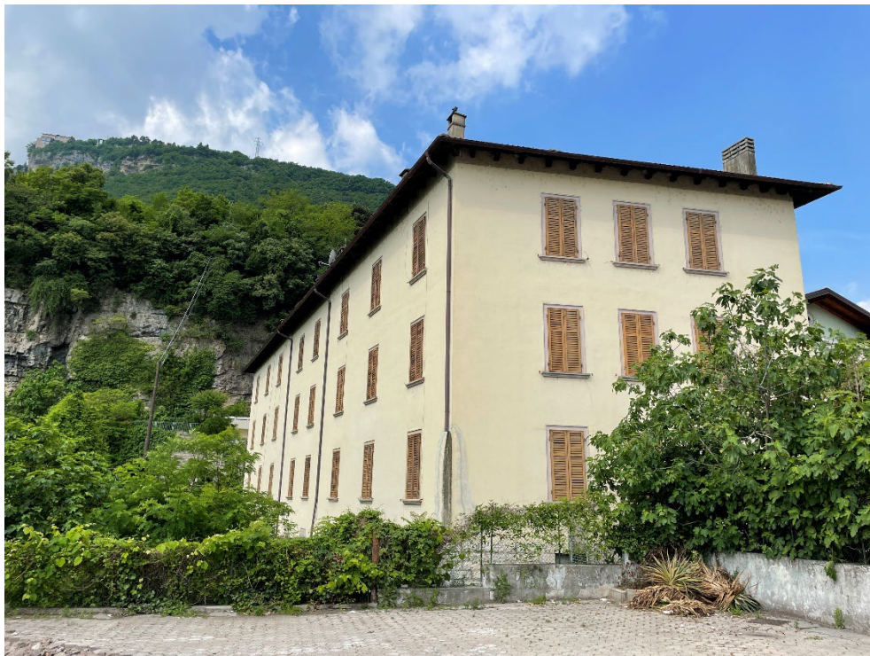
Foto 05 - Vista della p.ed. 2744 da sud-est
