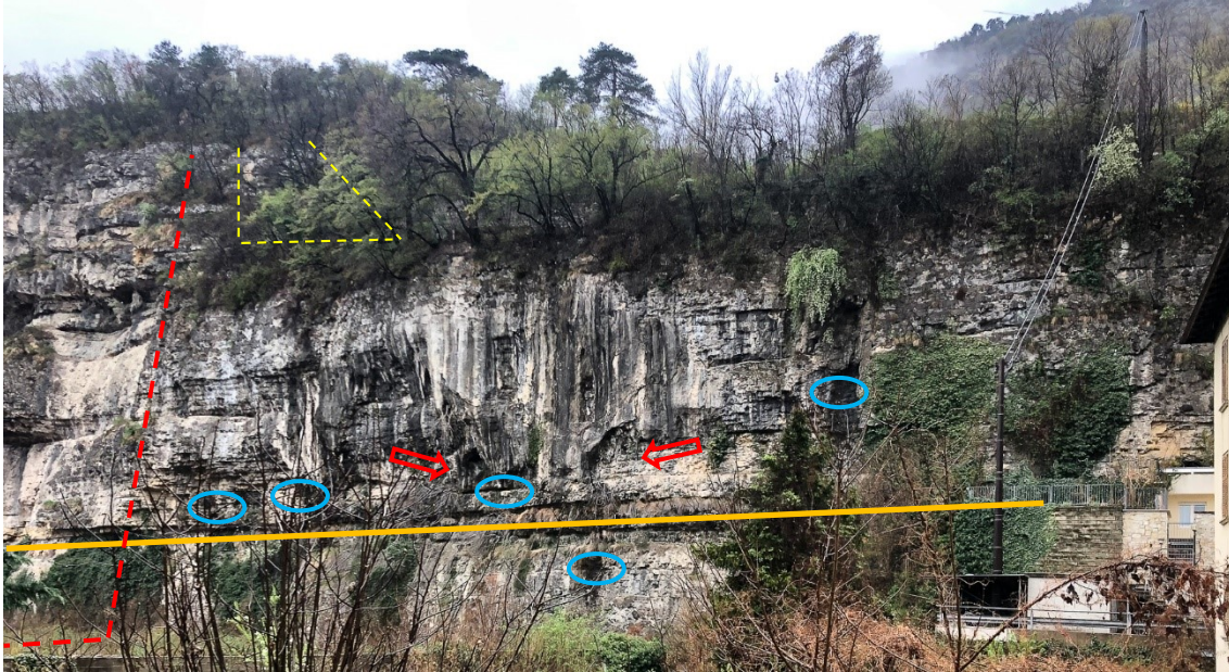
Figura 8 - Vista verso Sud Ovest della parete afferente al Comparto C (dagli edifici da demolire a destra fino al tratteggio rosso). Evidente la verticalità della parete, la presenza nella parte alta e centrale delle velature di calcite e alla loro base piccole cavità intercomunicanti (freccie rosse), il livello VUB2b (linea arancione) e le sorgenti fossili/emergenze idriche visibili (cerchi azzurri). Nella parte superiore (tratteggio giallo) si evidenzia la zona dei pinnacoli rocciosi da bloccare tramite chiodature puntuali ed eventuale posizionamento di una rete verticale paramassi interna al bosco.
