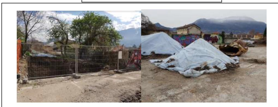
Scavo trincea Tr3 e scavo del serbatoio 1 con cumuli di terreno derivanti. Figure 8.11 e 8.9 della Relazione di fine lavori di bonifica ai sensi del D. Lgs. 152/06 - “Piedicastello S.p.A. Sito ex Italcementi e proprietà Piedicastello limitrofe - dott. geol. Luca Raffaelli - Settembre 2018”.
