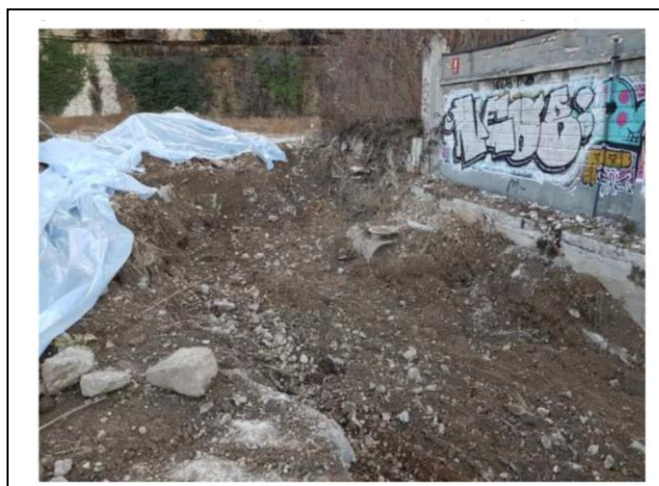
Scavo del serbatoio 2 e scavo zona serbatoio 3 non rinvenuto. Figura 8.10 della Relazione di fine lavori di bonifica ai sensi del D. Lgs. 152/06 - “Piedicastello S.p.A. Sito ex Italcementi e proprietà Piedicastello limitrofe - dott. geol. Luca Raffaelli - Settembre 2018”.
