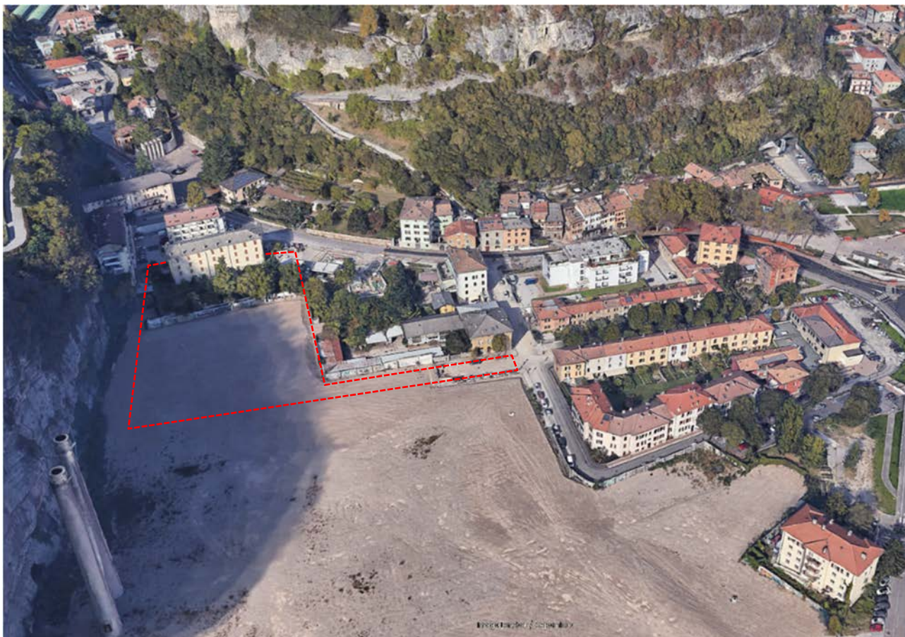
Figura 1: Inquadramento generale dell'area di Piedicastello con indicazione del lotto oggetto di intervento. Le principali sorgenti sonore della zona sono riconducibili alla rete viabilistica.
