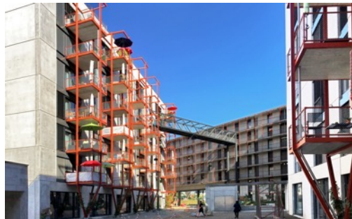
Kraftwerk1 Zwicky Süd 2015
