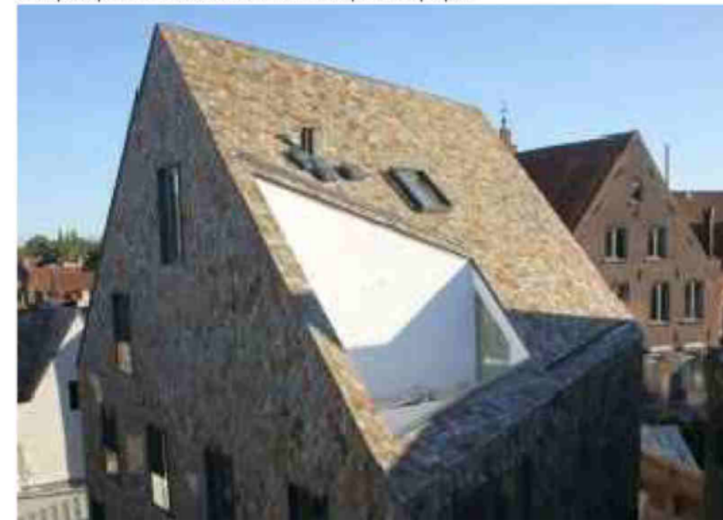
Esempio copertura inclinata con terrazze in falda per uno o più piani
