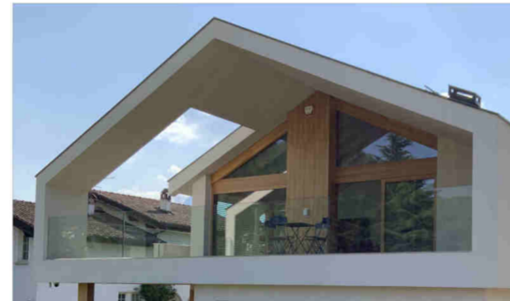
Esempio copertura inclinata con terrazze in falda
