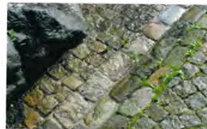
Canaletta scolo acque
