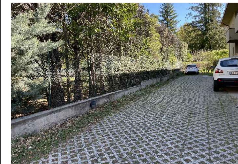
5. Vista lato sud esterno
