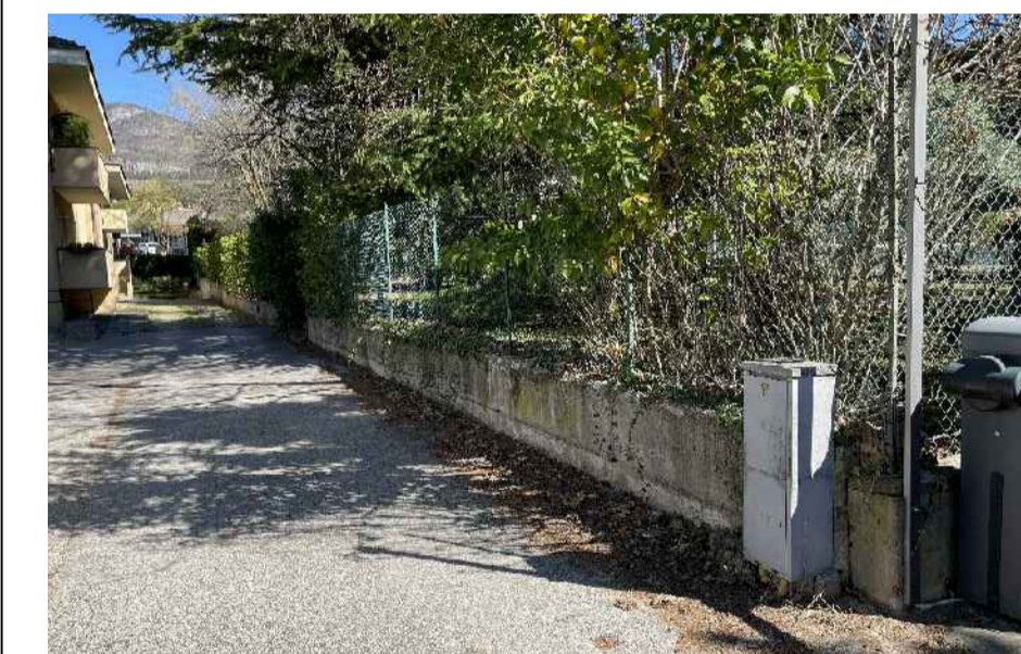
1. Vista lato ovest esterno
