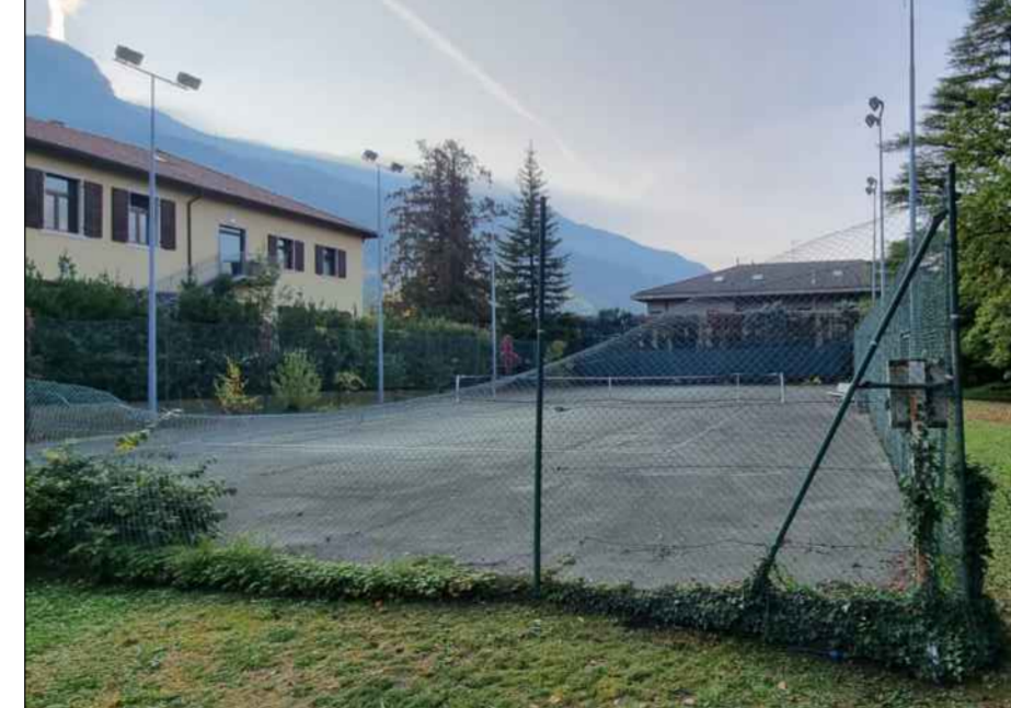
4. Vista lato nord interno
