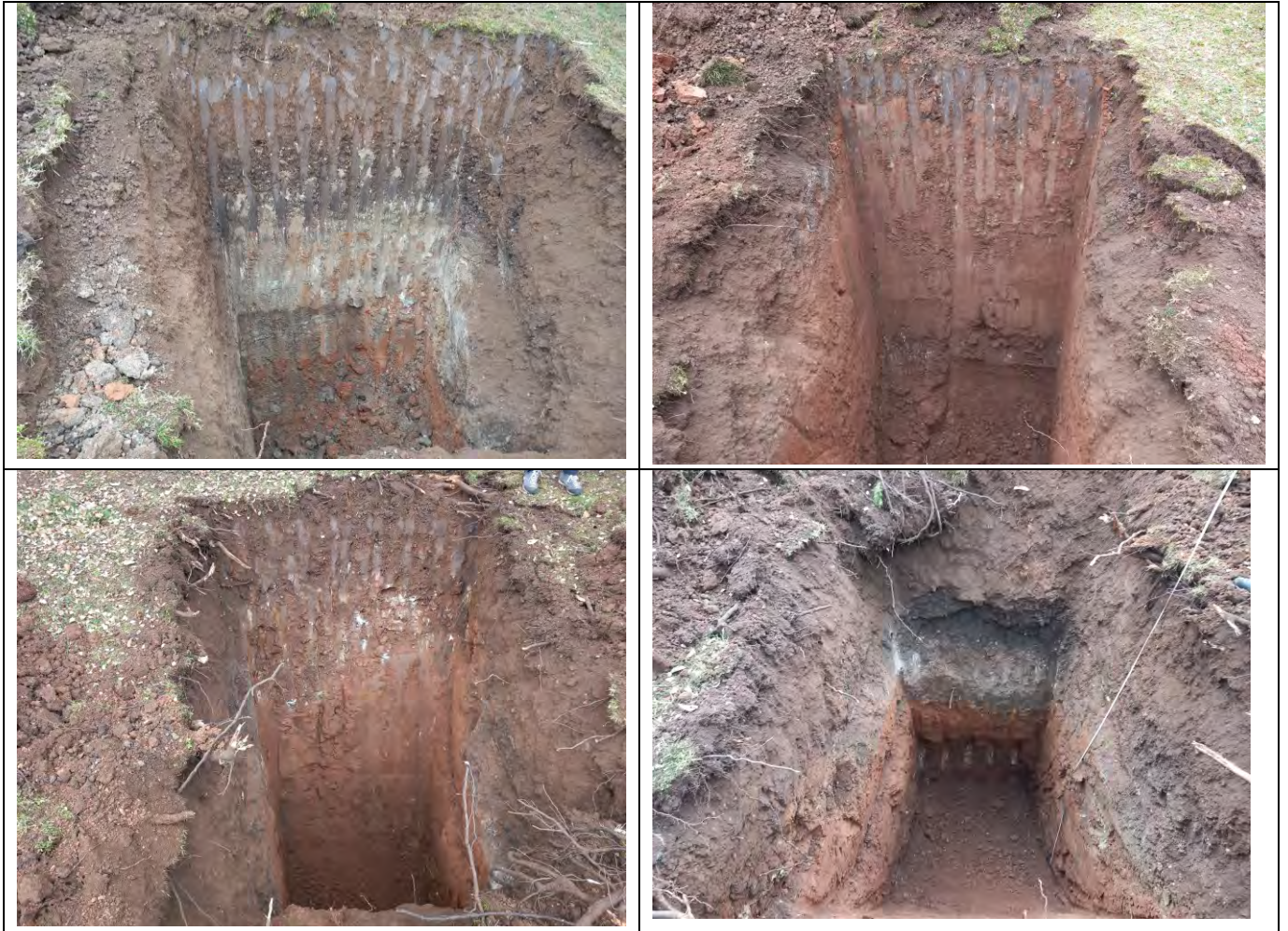
Fig. 12: risultati scavi esplorativi superficiali
