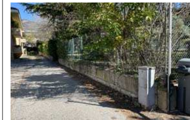
1. Vista lato ovest esterno
