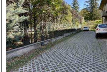
5. Vista lato sud esterno
