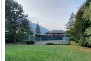
3. Vista lato nord interno
