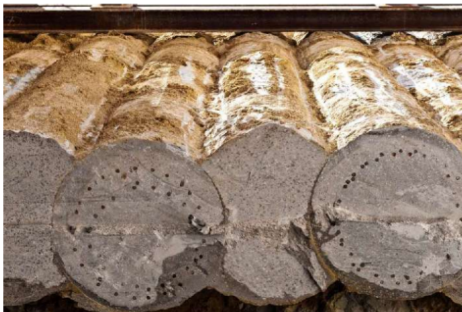
Fig. 3b.2: sezione su una serie di pali secanti.
