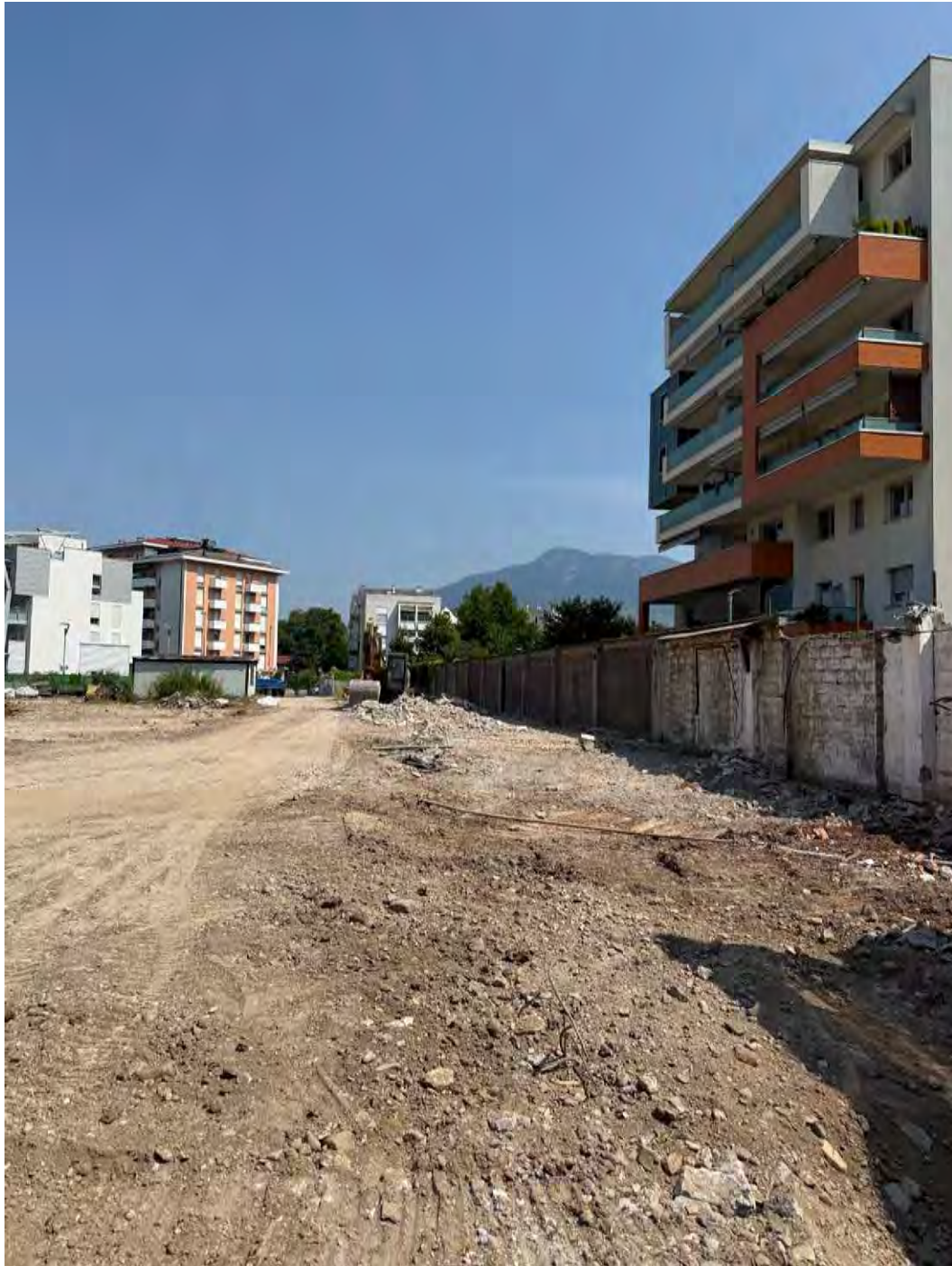
FOTOGRAFIA 3 – PARTE SUD-EST LOTTO
