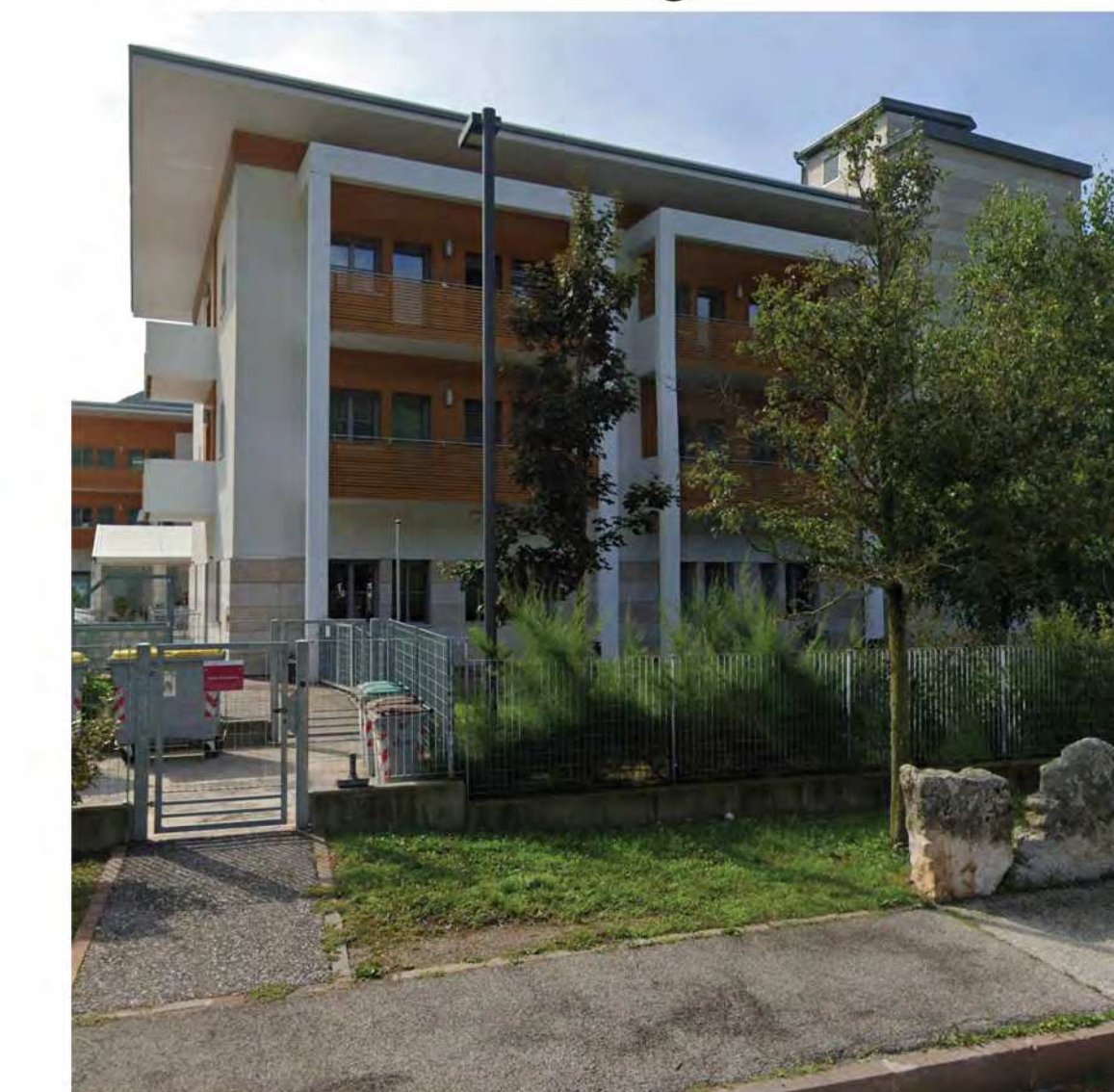
FIG. 6 - Esempio edificio limitrofo 6
