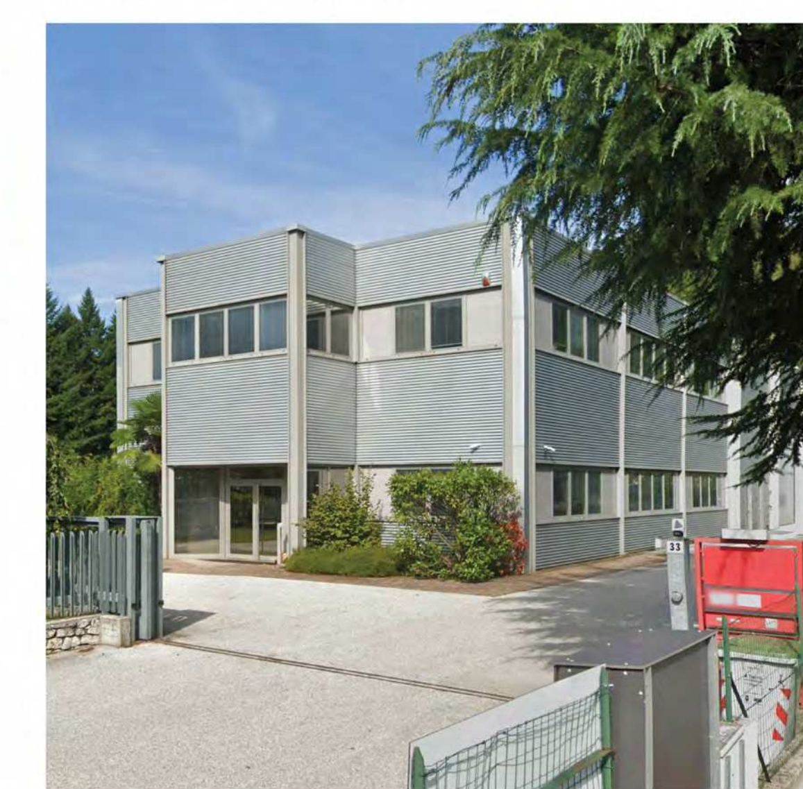
FIG. 9 - Esempio edificio limitrofo 9
