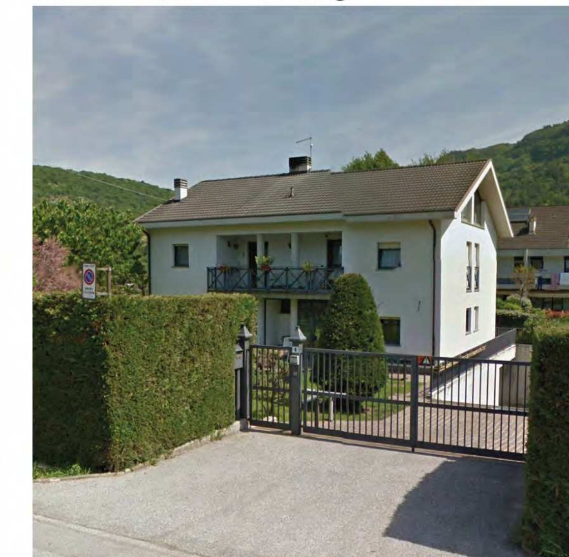
FIG. 7 - Esempio edificio limitrofo 7
