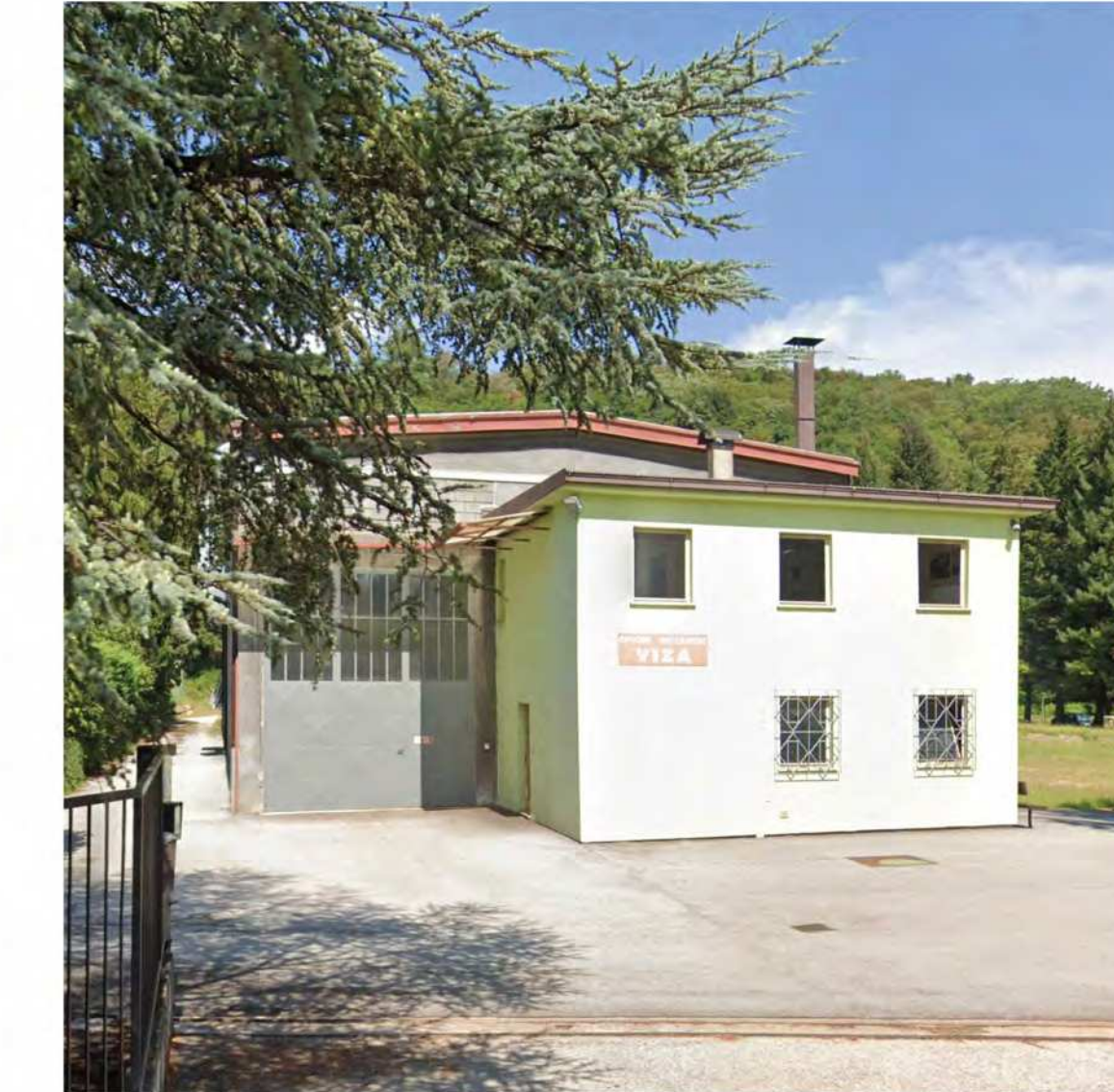
FIG. 10 - Esempio edificio limitrofo 10
