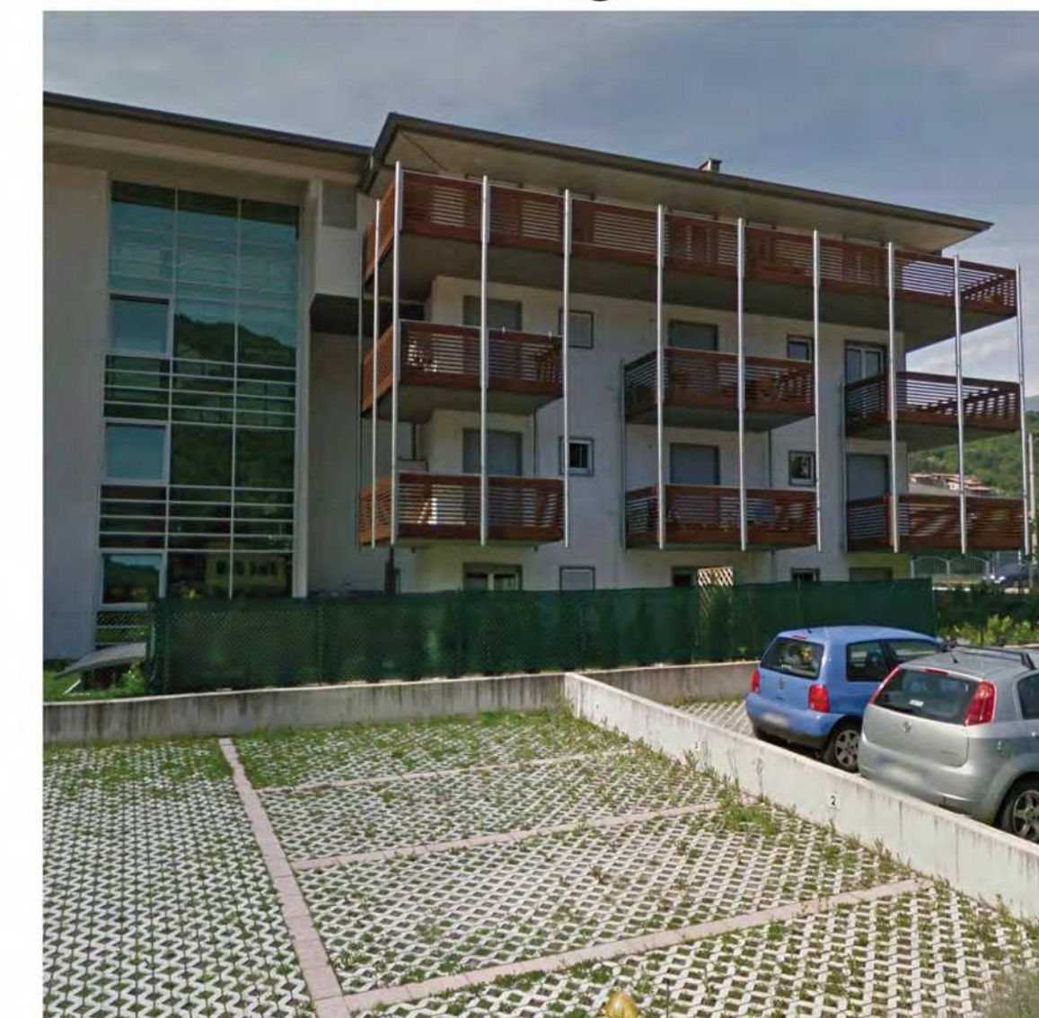
FIG. 3 - Esempio edificio limitrofo 3
