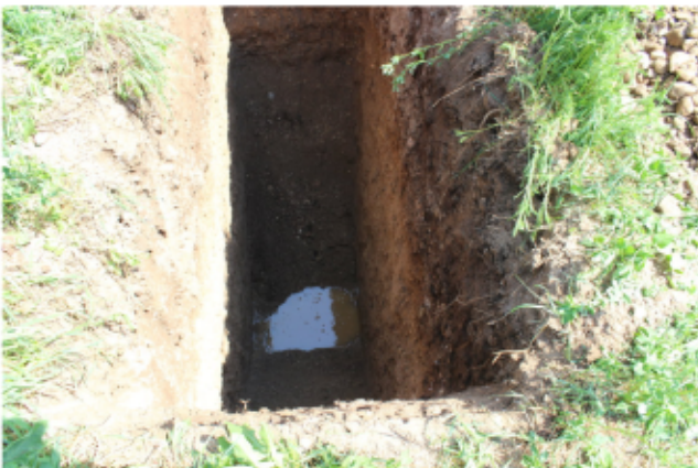
Foto 2.2 e 2.3: la trincea 1 con la falda al contatto del terreno B ed il materiale A grossolano.
