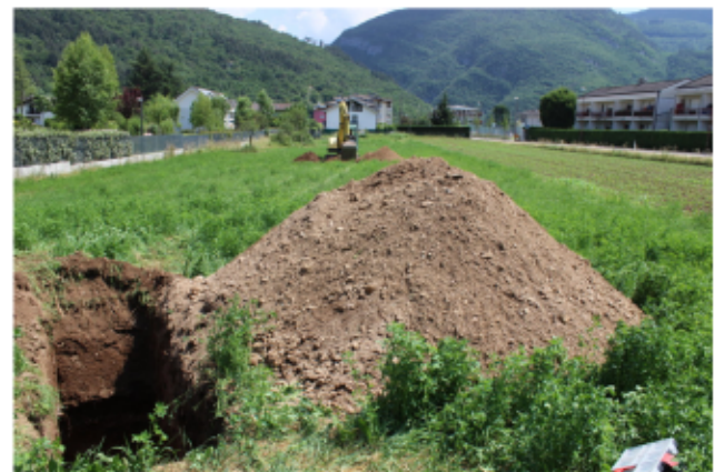
Foto 2.2 e 2.3: la trincea 1 con la falda al contatto del terreno B ed il materiale A grossolano.
