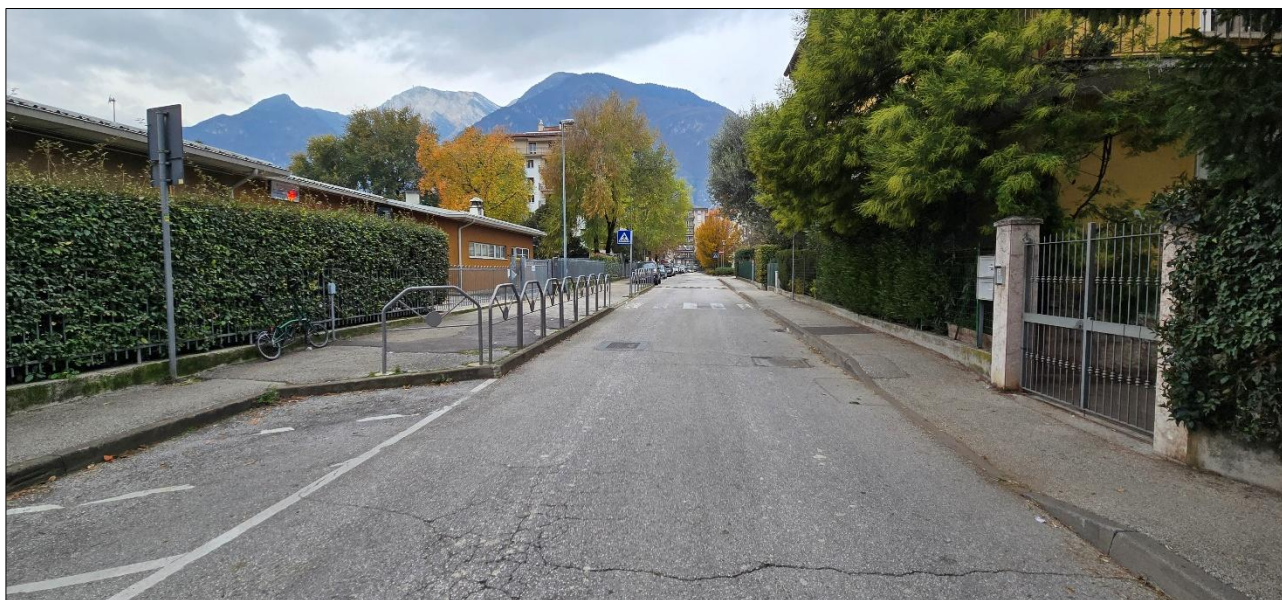
Tratta di accesso alla scuola dell'infanzia Piccolo Mondo: stato di fatto
