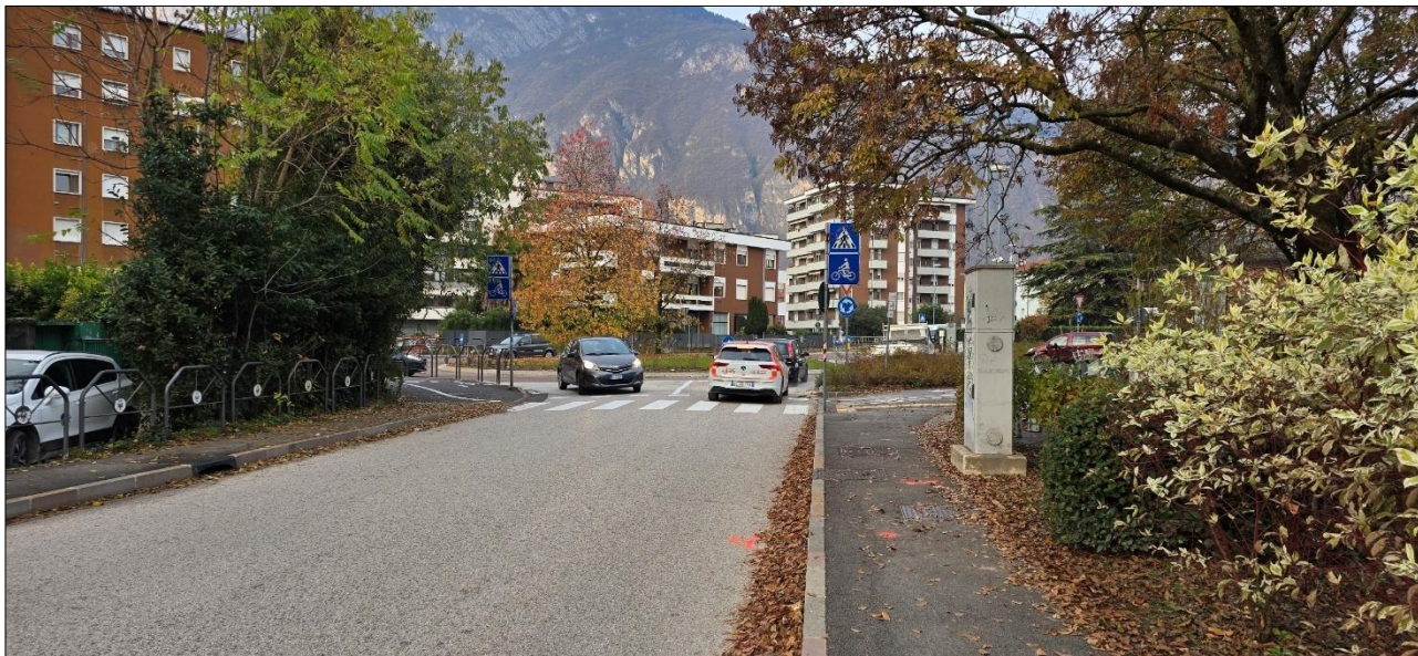
Attraversamento ciclopedonale in corrispondenza della rotatoria con via Degasperi: stato di fatto
