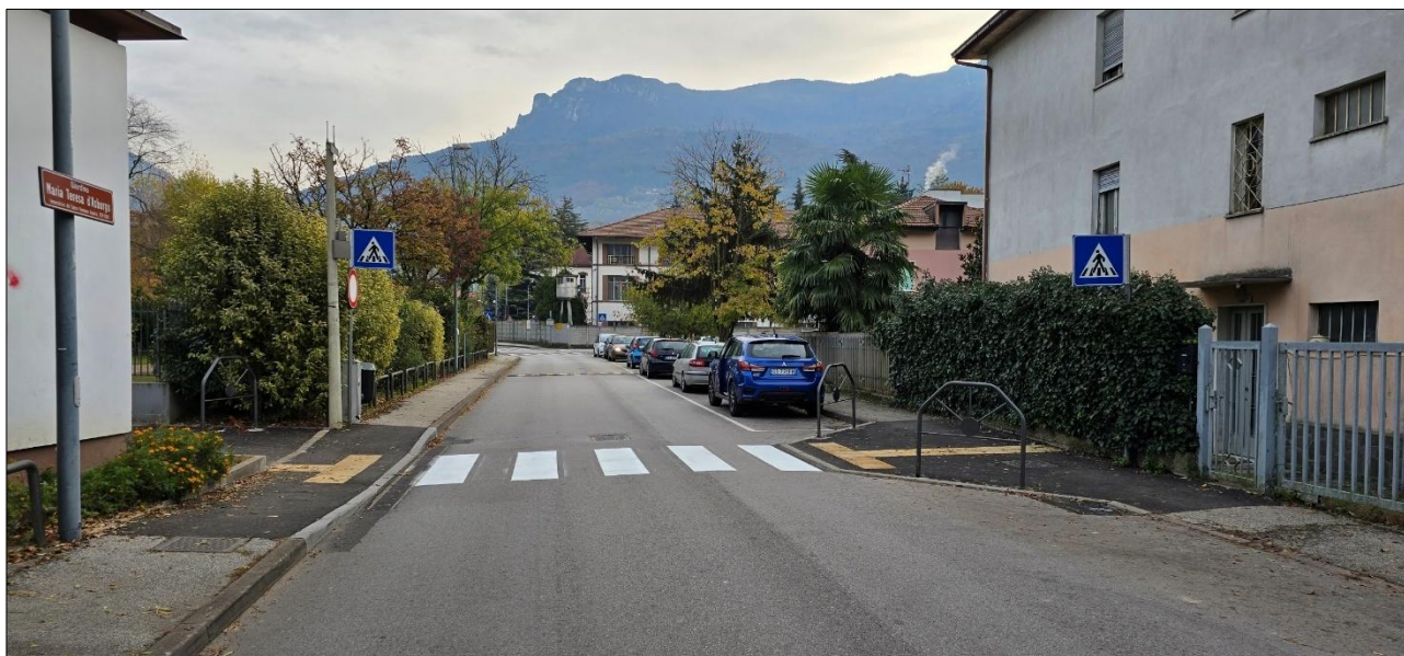
Attraversamento pedonale di accesso al Giardino Maria Teresa d'Asburgo: stato di fatto
