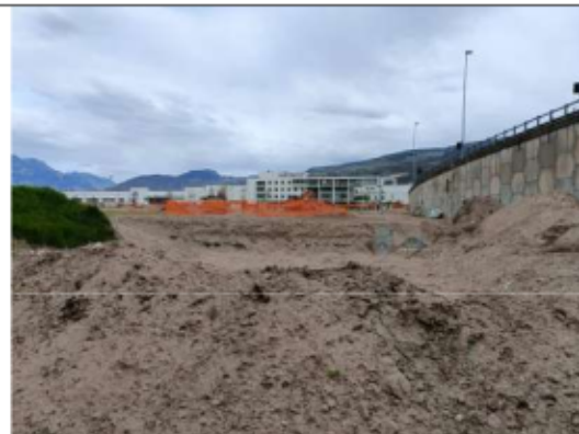
Lavori di innalzamento del p.c.
