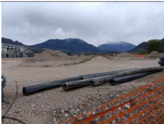
Lavori di innalzamento del p.c.
