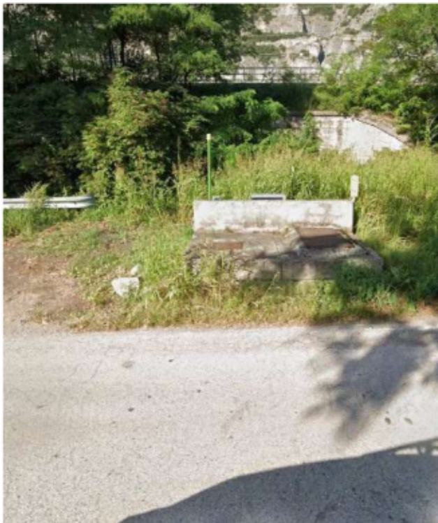
Presa di scarico del Lavisotto su Fossa Interporto Ramo Nord lungo via Kempton
