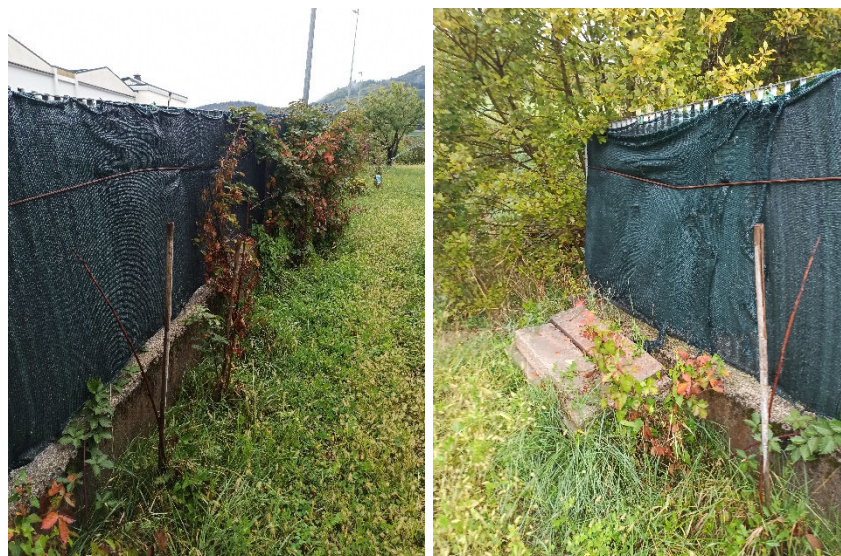
figura 17: Immagini del Rio Bozon – Punto 4. Muro di recinzione esterno – lato sud. Altezza = 0.3 – 0.8 m.
