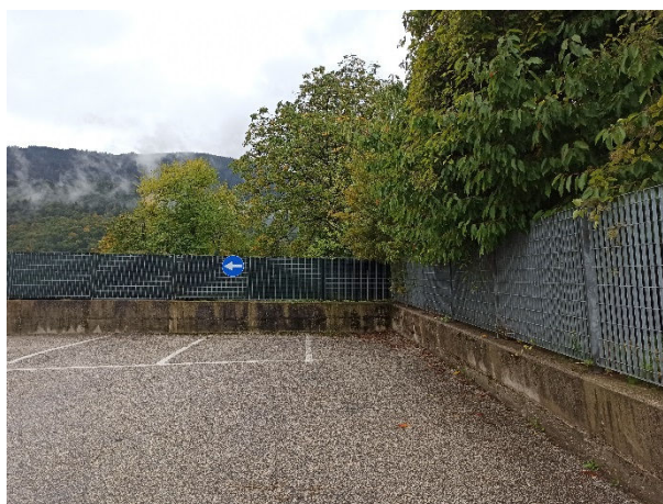
figura 18: Immagini del Rio Bozon – Punto 4. Muro di recinzione interno al piazzale della caserma – lato sud.
