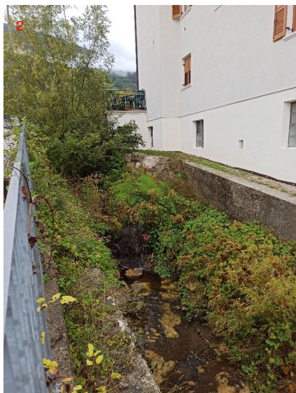
2 – Opera spondale in cemento a monte a fianco della caserma dei Vigili del Fuoco.
