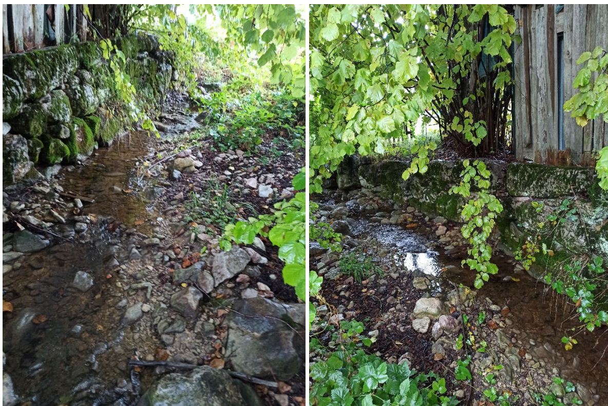
figura 15: Immagini del Rio Bozon – Punto 1. Opere spondali in massi sciolti e massi cementati.
