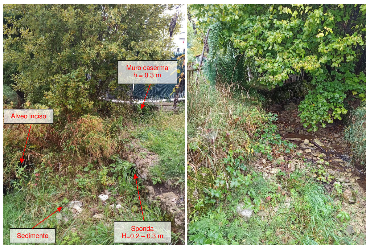
figura 16: Immagini del Rio Bozon – Punto 2. Alveo a monte della caserma dei Vigili del Fuoco. Punti critici: altezza alveo ridotta a causa del deposito di sedimento in alveo e altezza minima del muro della caserma.
