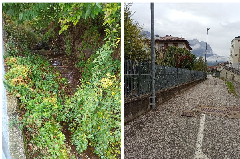
figura 19: Immagini del Rio Bozon – Punto 4. Alveo e muro interno del piazzale della caserma – lato ovest.
