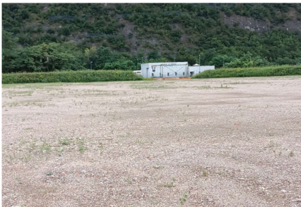
figura 12: Punto 6: Idrovora Interporto.
