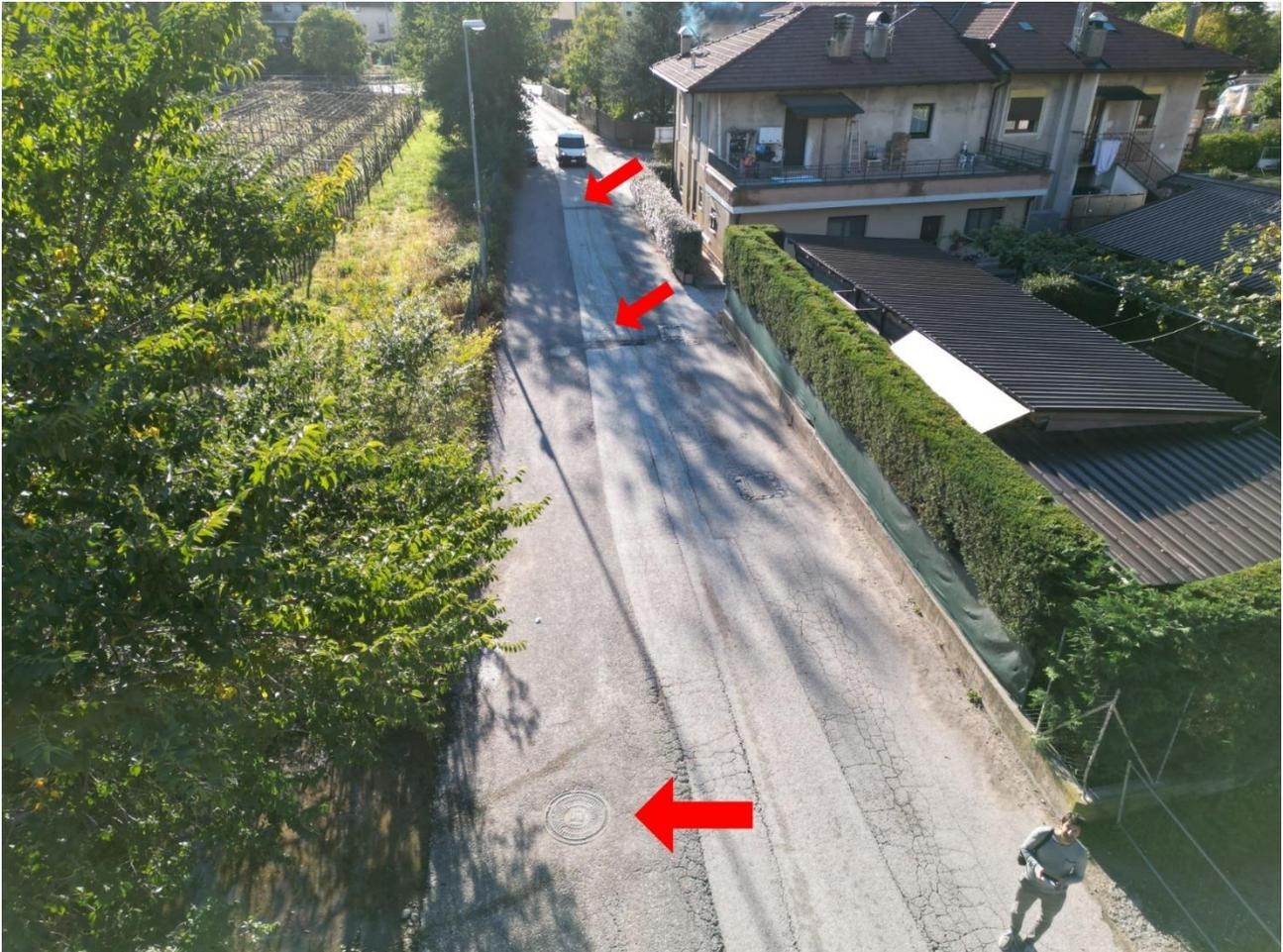
Figura 2: Vista verso Sud di via Pont dei Vodi. Le frecce evidenziano il pozzo con chiusino circolare di ispezione del collettore e i tracciati di collegamento di 2 delle caditoie presenti sulla strada.
