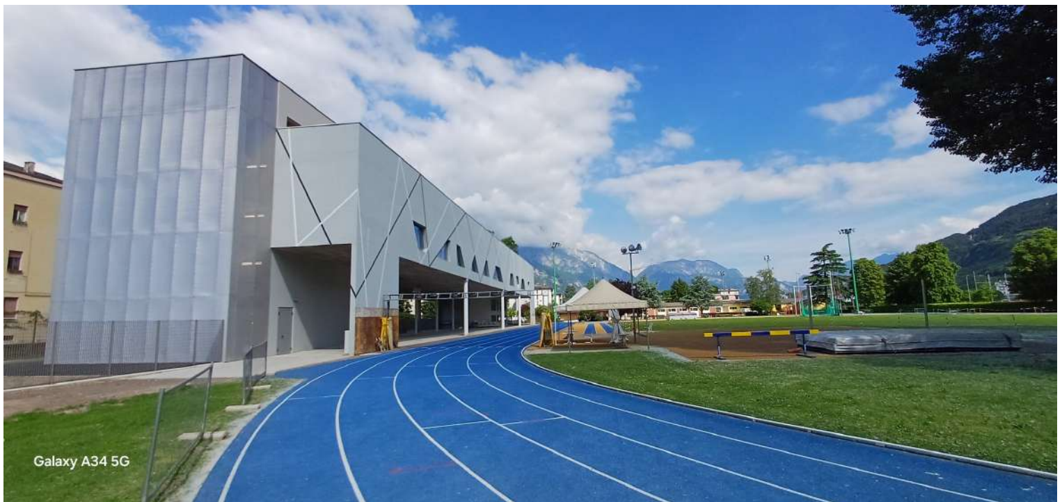
Altro affaccio della pista indoor
